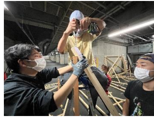
図4. 治具を用いた木材の斜め方向の孔あけ加工
