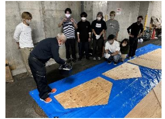
図5. 防滑性塗料の施工
